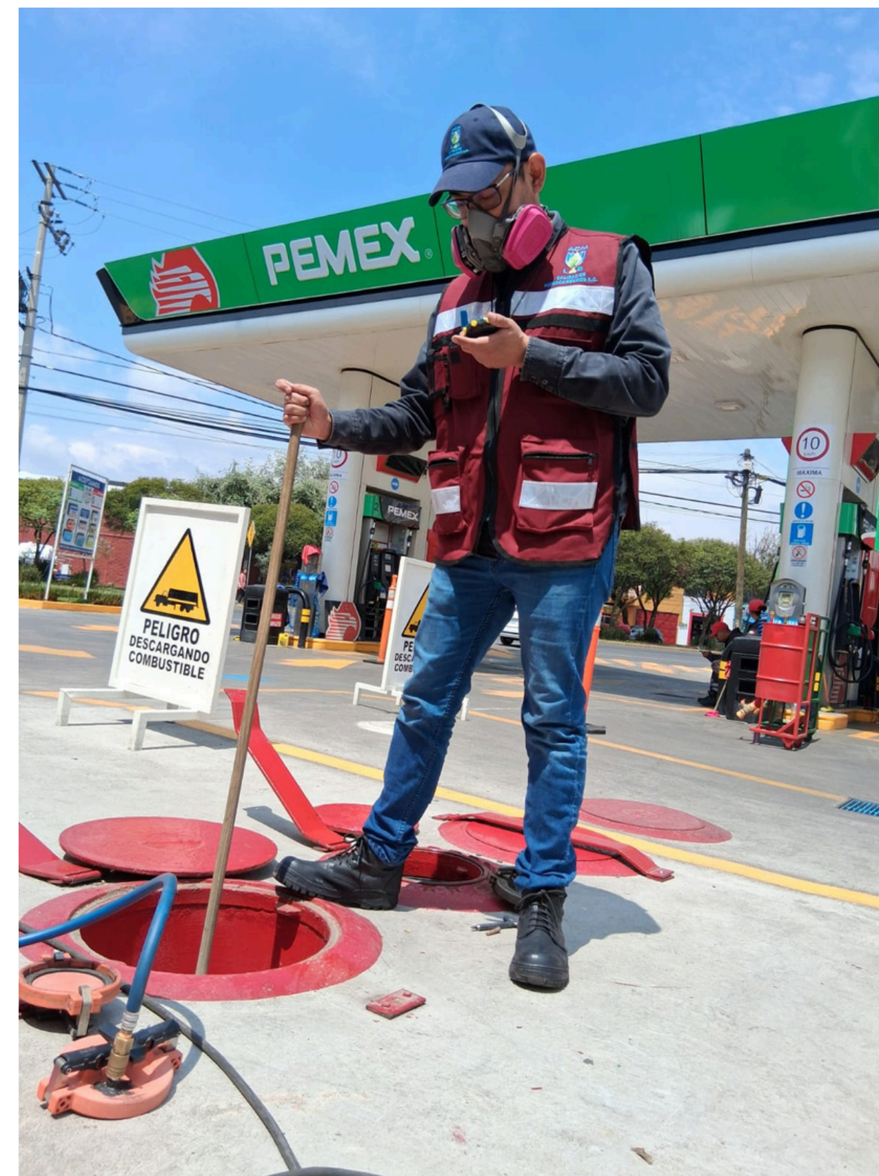
Prueba - Interconexión de tuberías y líneas de vapores en los tanques de almacenamiento y dispensarios
